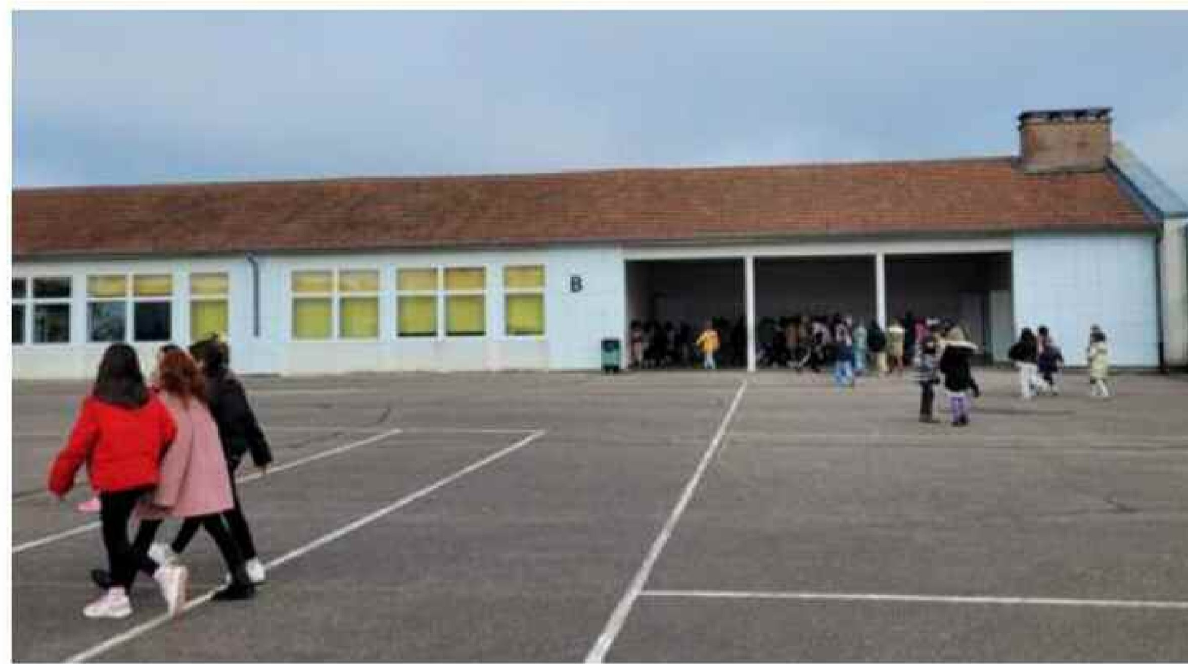
Les bâtiments B et C du groupe scolaire, construits dans les années 1960, nécessitent des travaux.
